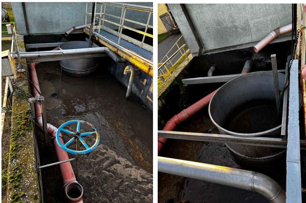
Fot.3. Komora beztlenowa ze zbiornikiem predenitryfikacji
