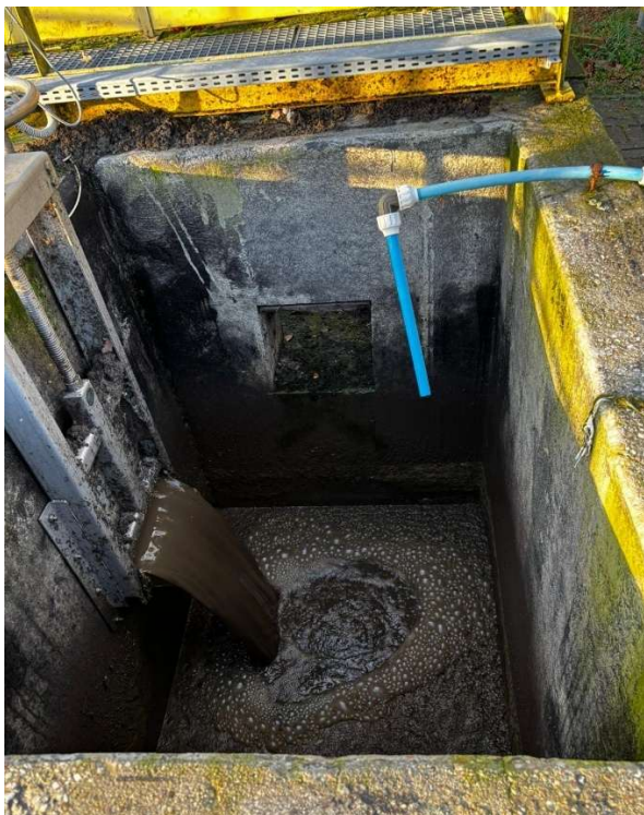
Fot.9.Komora odpływowa do osadnika wtórnego
