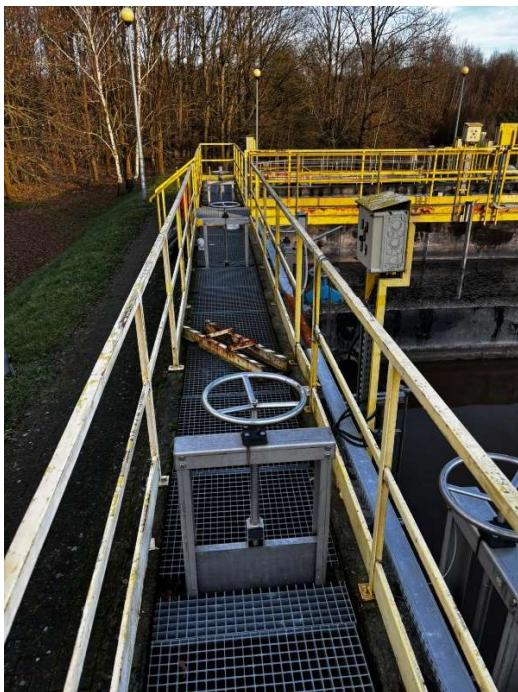
Fot.8.Widok na zastawki do kanału zewnętrznego
