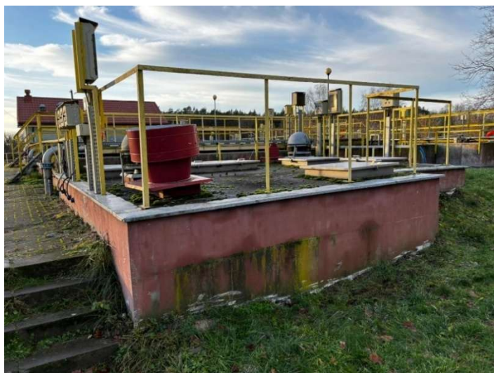
Fot. 12. Przepompownia recyrkulacyjna osadu wtórnego
