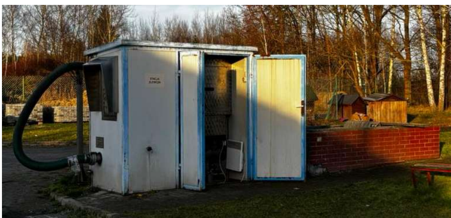
Fot.1. Punkt zlewny ścieków dowożonych wraz z kratą płaską
